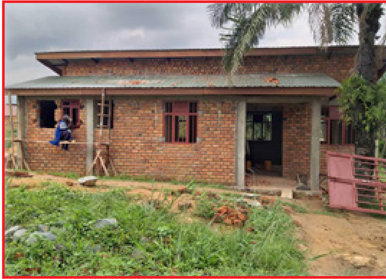
Photo 10 : Salle technique à Tshikapa en cours de construction par SANRU sous le financement ASDI
