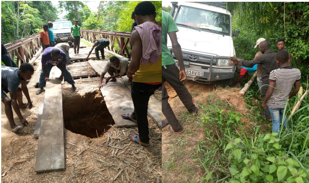
Etat de Route menant à la ZS Yakusu/Tshopo : participation communautaire permettant la réalisation de la mission sur terrain.
