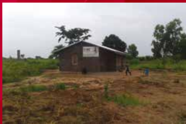
Photos 4 : CS Kola Moyo, fin des travaux
