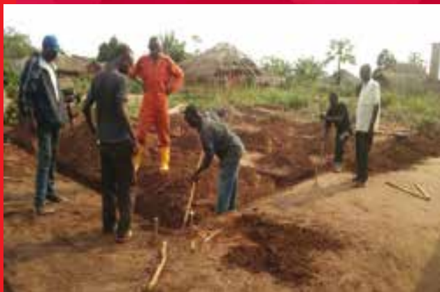
Photos 1 : Etape de fouille lors de la construction du CS Tshimbangu
