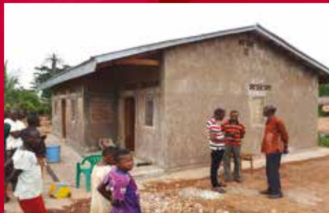
Photos 2 : Evolution des travaux au CS Tshimbangu
