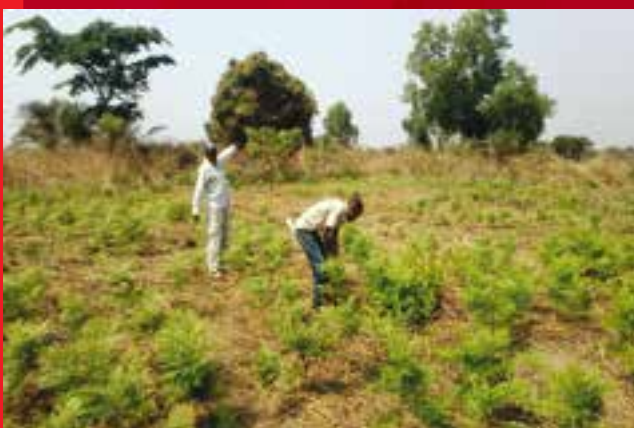
Photos 3 : Zone de construction du CS Kola Moyo, en pleine défriche
